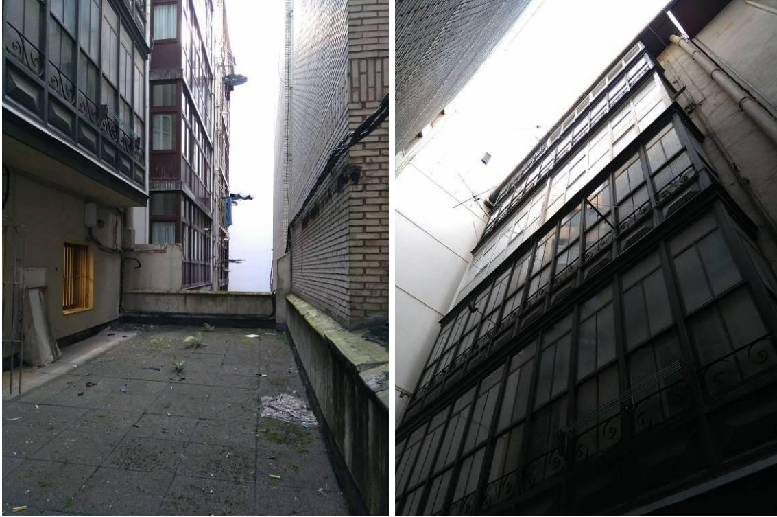
Patio fachada posterior a sur
